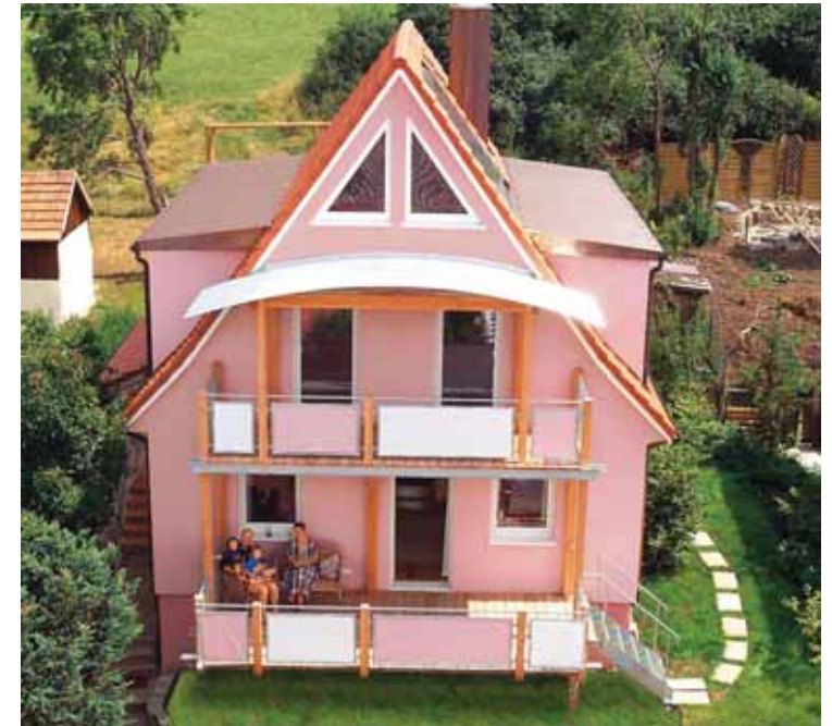
Eine Sanierung wertet ein in die Jahre gekommenes Familienheim nicht nur optisch auf, sondern verbessert auch dessen Energieeffizienz nachhaltig. Foto: djd/Sto AG
