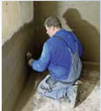
Mitarbeiter Carsten Schneider dichtet eine Wand mit spezieller Dichtungsschlämme ab.
