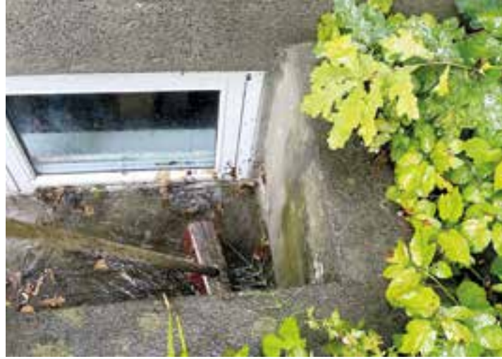
Wer rechtzeitig die Anschlüsse der Kellerfenster abdichtet, minimiert bei Hochwasser das Risiko von Wasserschäden im Gebäude. Foto: Scharvik/istockphoto.com/Triflex/akz-o
