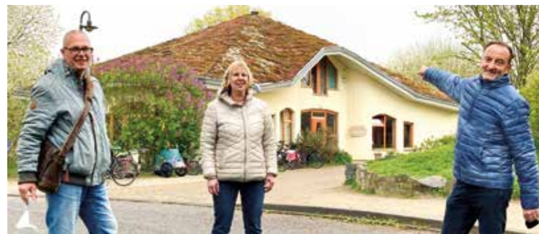
V.l. Uwe Dwornik, Maria Kroll-Fiedler und Rainer Wolf von der Geschäftsstelle Klimaschutz der Stadt Soest vor dem Gebäude des Waldorfkindergartens Soest mit einem begrünten Dach. Foto: Stadt Soest
